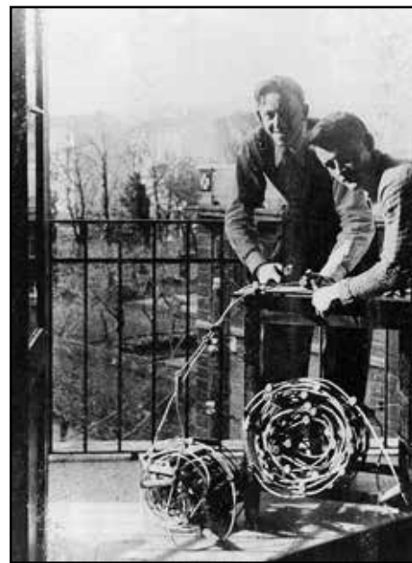
Si costruiscono le scalette in casa. (Archivio CAT)
