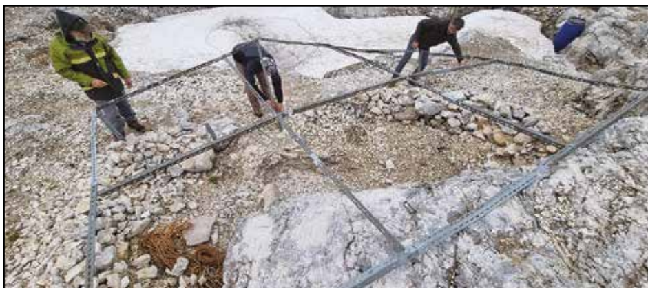
Montaggio del tendone comune.
