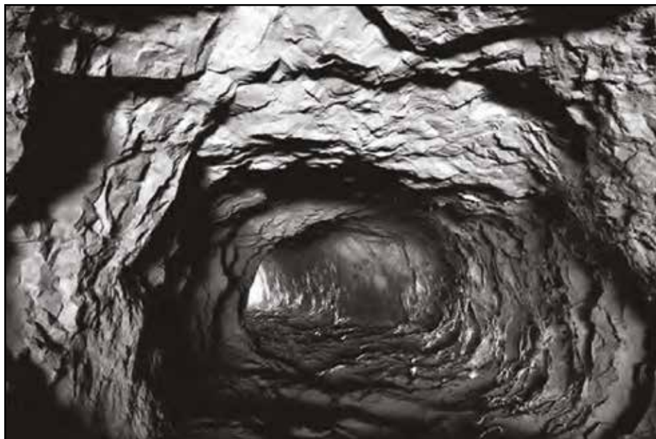
Túnel Aliviadero Presa Las Niñas.
