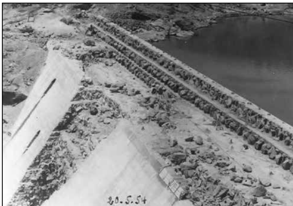
Vista del doppio muro della diga- 3ª Fase.
